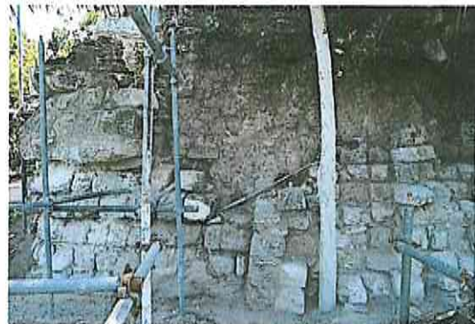
Trabajos de restauración en relieves, fachada oeste.
