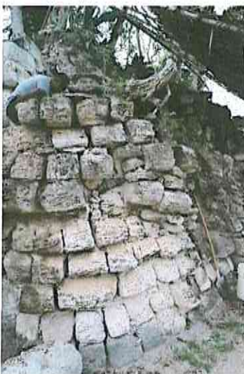
Relieves en B-24, vista desde la esquina noroeste, estado de los sillares antes de iniciar con el proceso de consolidación.
