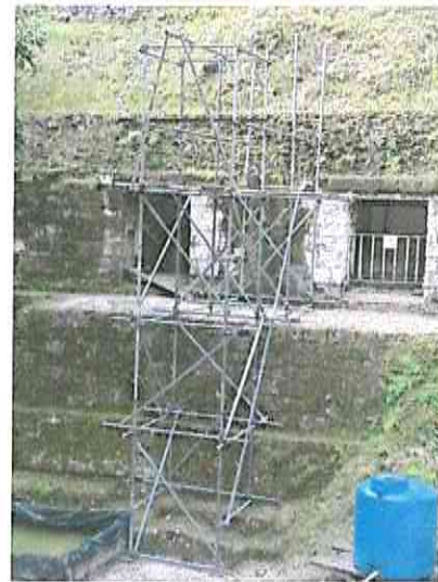
Edificio 389 en el sitio arqueológico Yaxha, apuntalamiento de bóvedas en el interior del edificio.
